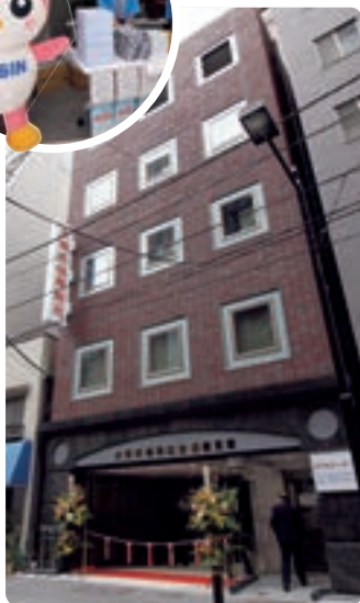
建物の全容 5階建ての建物で、2階が営業 窓口となっています。
